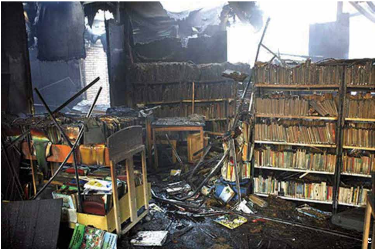
La bibliothèque de Villiers-le-Bel (95) incendiée en novembre 2007.
